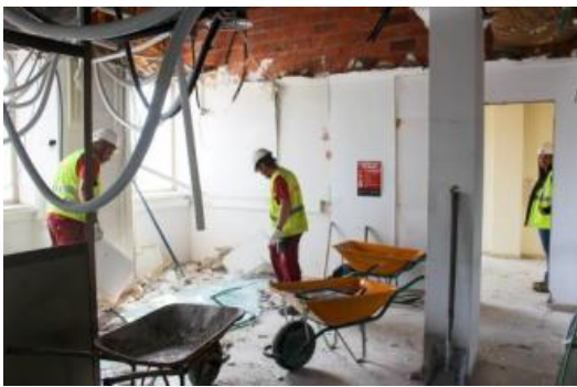
Operaris treballant en les obres per ampliar i reformar les Urgències del Trueta, aquesta setmana.
