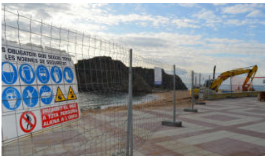
Obres de reconstrucció del mur de sa Palomera
