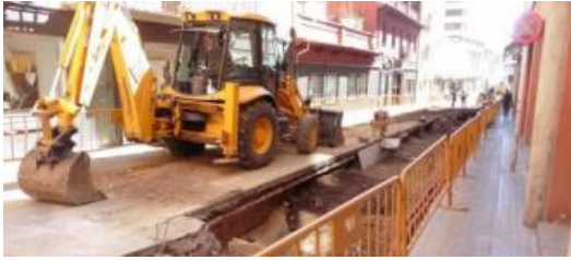
Han començat les obres d'urbanització del carrer Serra i Ginesta, a Olot
