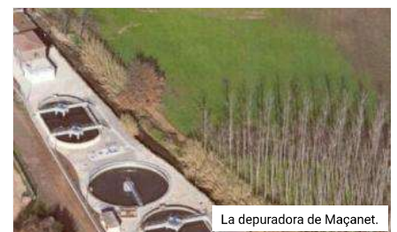
La depuradora de Maçanet.
