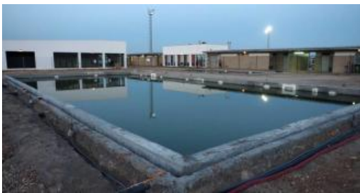
El punt actual de les obres a la piscina municipal de Porqueres.
