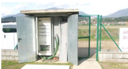
Un dels armaris del camp de futbol d'Argelaguer, obert i amb les connexions tallades
