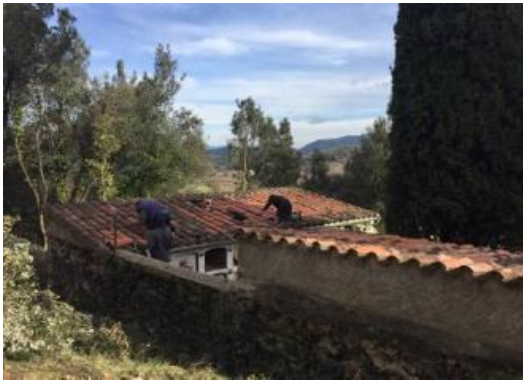
Els operaris treballen en la reparació de la teulada
