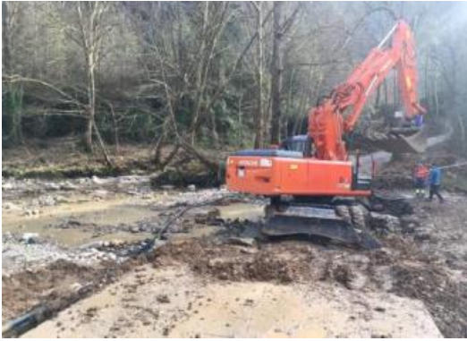
La màquina treballa en la desviació de l'aigua .
