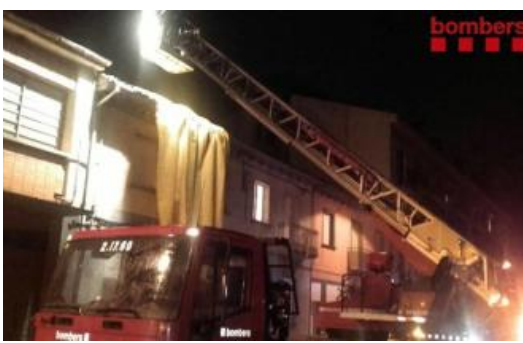
Olot S'esfondra la teulada d'una casa, sense provocar ferits
