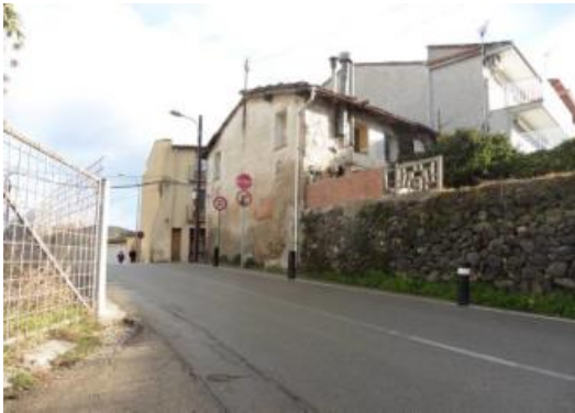
La casa del carrer Sant Cristòfol que serà enderrocada.
