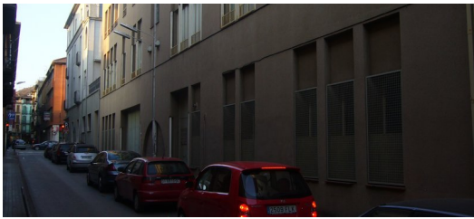
L'edifici de Can Monsà és al carrer Fontanella de la capital garrotxina, a tocar del centre de la ciutat Foto: J.C.
