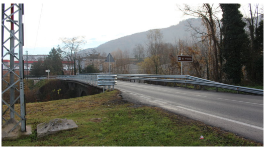
El pont del Salt, l'estructura del qual quedarà modificada quan
