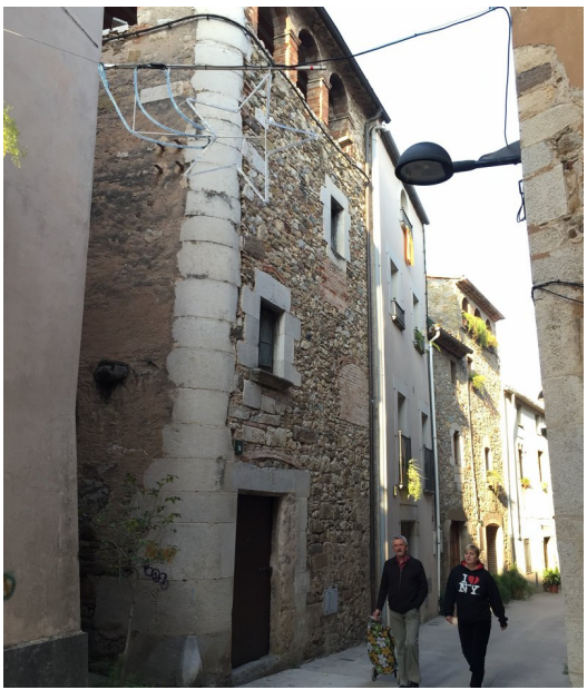
La Casa Feliu , dies abans de l'inici d'obres de consolidació de l'estructura, el 2015 Foto: J.N.
