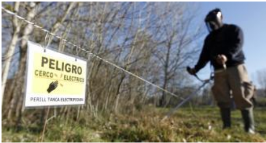
Un empleat instal·lant la tanca que s'ha posat a Salt
