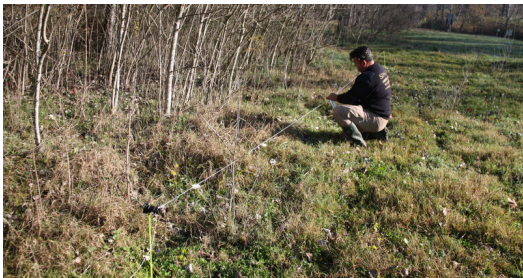
La instal·lació d'una tanca electrificada
