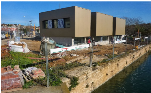
Les obres de la nova comissaria de la policia local de Banyoles, dimarts al mat Foto: R.E.
