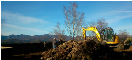
Una màquina i tècnics de l'obra, ahir al matí al lloc on s'aixecarà el nou equipament Foto: R.E.
