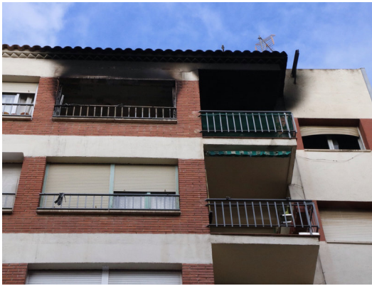
L'edifici afectat pel foc Foto: ACN.
