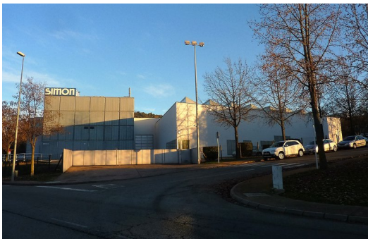
Les instal·lacions de Simon al polígon del Pla de Baix d'Olot Foto: R.E.
