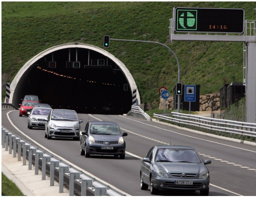
Una de les boques del túnel de la Codina. Foto: EL PUNT AVUI.
