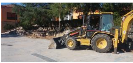
Els treballs de renovació de la pista poliesportiva
