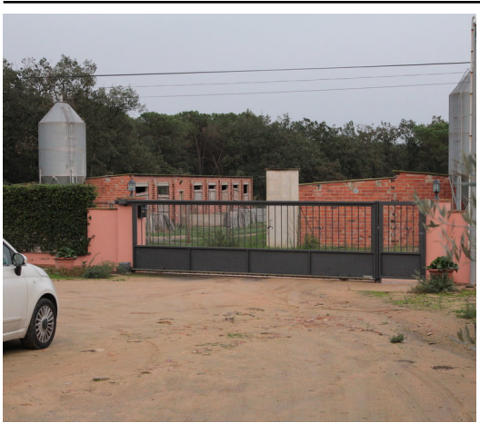
Les naus de la granja porcina, a l'altra banda del camí d'accés que separa l'explotació de l'habitatge de Can Cateura, al nucli llagosterenc de Panedes Foto: E.A.
