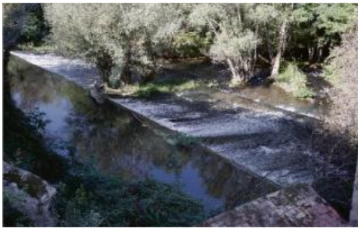
La zona de la Pilastra de Bescanó on hi ha la comporta.
