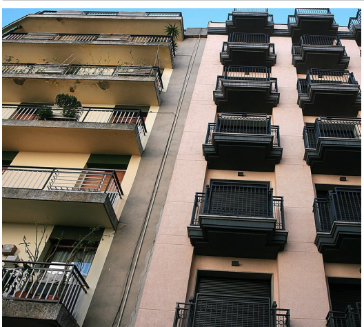
Uns edificis de Lloret, que farà revisió cadastral. Foto: EPA.
