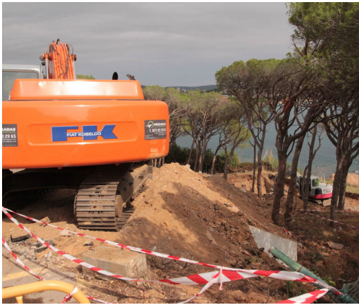
La zona on es fan els treballs que han de servir per fer la zona de la piscina, en una imatge d'ahir al matí Foto: E. AGULLÓ.
