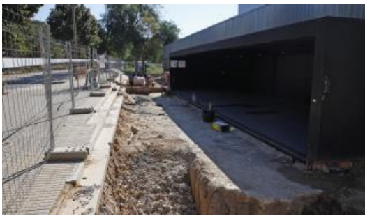
Avancen les obres del CAP Salt 2
