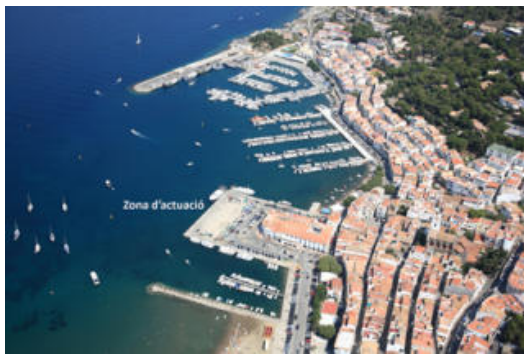
Imatge de la zona on es fan les obres.
