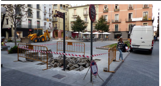
Un detall de la plaça Major, a l'extrem del carrer Major, amb les obres ja iniciades i sense les faroles velles. Foto: J.C.
