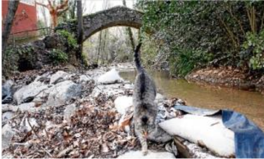
La resclosa del Molí de les Pipes està feta amb sacs de sorra i pedres.
