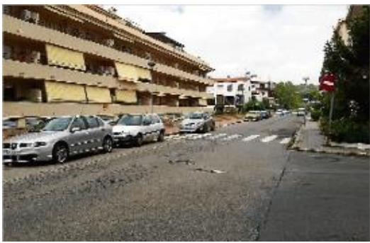
El tram del carrer del Mar on s'executarà el projecte del nou col·lector.
