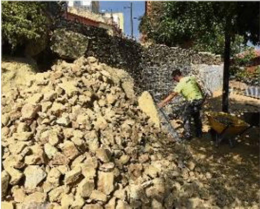
L'Ajuntament reforça un antic mur de pedra
