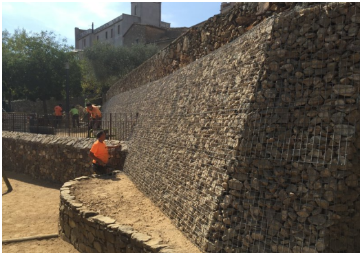
Les obres de reforç del mur de pedra. Foto: CANAL AJUNTAMENT.
