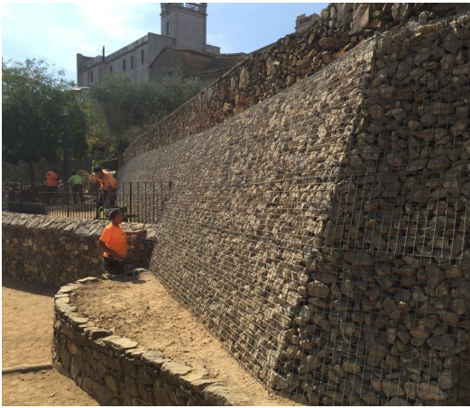
Reforç d'un mur Foto: U.C. /CANAL AJUNTAMENT.
