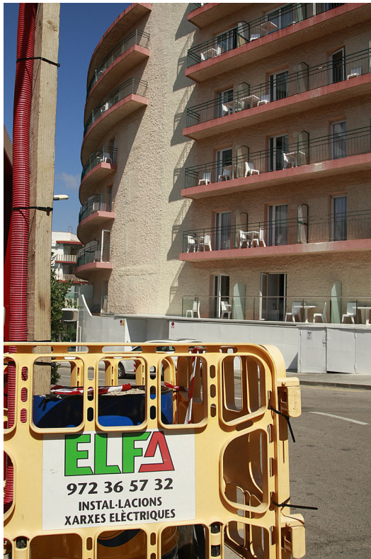
Vista de l'hotel Sun Village de Lloret de Mar, que va patir un incendi d'jous passat Foto: MANEL LLADÓ.
