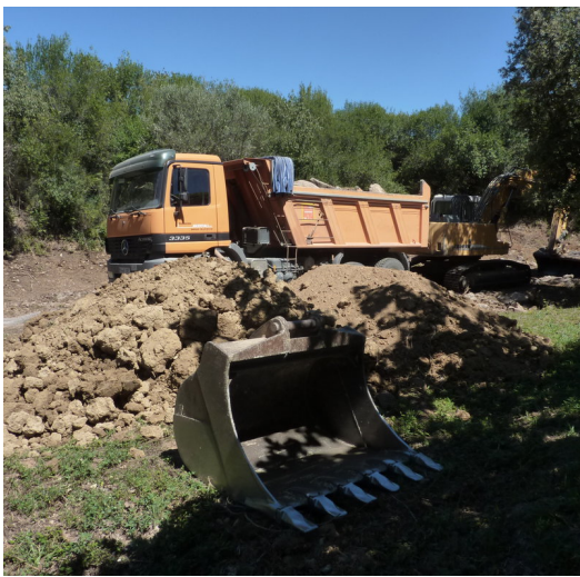
Un camió i una màquina treballant en el moviment de terres per fer el parc. Foto: R. E.
