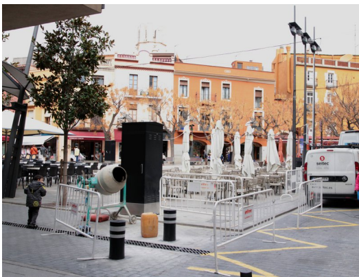
Obres d'enllumenat a la plaça Nova, a la primavera Foto: E.A.
