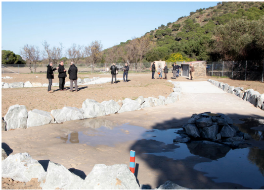
La planta de regeneració d'aigua del Port de la Selva, en una imatge d'arxiu Foto: JOAN SABATER.
