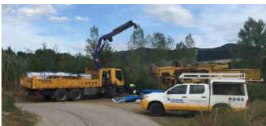
Un moment de l'inici de les obres d'un pou de reserva.
