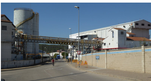
Vista parcial de la planta paperera de Sarrià de Ter, antiga Torraspapel, en una imatge presa dilluns passat Foto: J.O.
