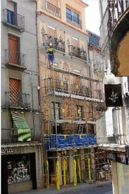
Els operaris ahir desmuntaven la bastida d'una façana a Olot.
