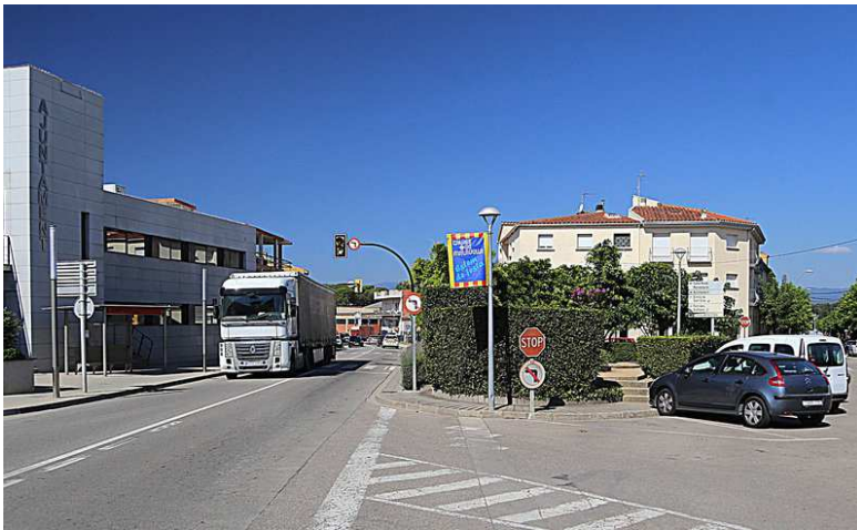
Una imatge del carretera Llagostera, en l'encreuament amb l'avinguda Catalunya, dimarts. La marquesina de l'autobús i els semàfors desapareixeran per donar pas a una rotonda Foto: M. LL.
