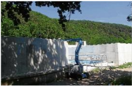
La depuradora nova en estat molt avançat, ahir al matí.
