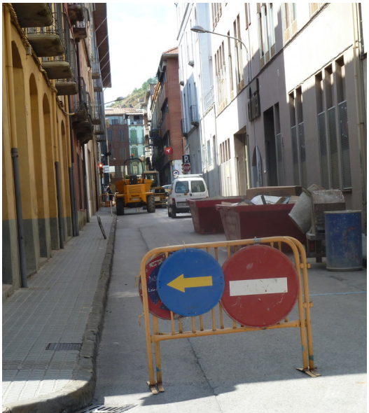
L'últim tram del carrer Fontanella, el que desemboca al Mulleras, ja tallat i a punt de l'inici de les obres. Foto: J.C.
