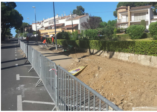
Un sector dels treballs que realitzen actualment en un tram de vorera de la carretera de La Fosca Foto: EPA.
