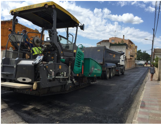
Obres de pavimentació al carrer Fivaller Foto: MARC SUREDA.
