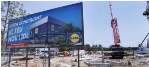
Les obres de la construcció del supermercat Lidl, a la plaça de Salt
