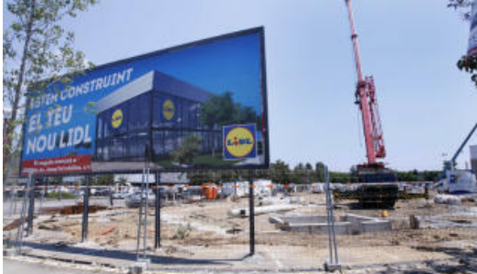
Construcció del Lidl a la Plaça de Salt
