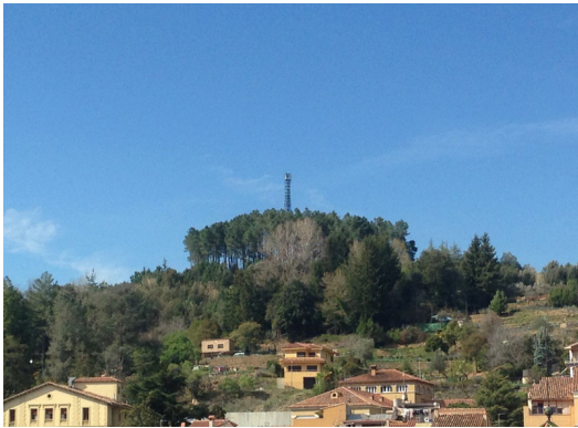
Una imatge de la torre de comunicacions del turó del Pi, a Arbúcies Foto: EL PUNT AVUI.
