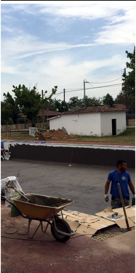
Les obres de la piscina de la Canyera van començar el 13 de juny passat.
