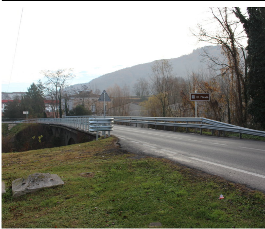
Una vista general del pont que aviat serà objecte dels treballs d'eixamplament i de millora. Foto: J.C.
