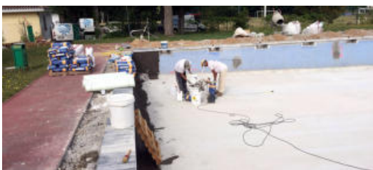
Treballadors adequant la piscina municipal de La Canyera
